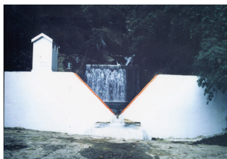
照片 2 1988 年八一四水災災後之溪頭量水堰
