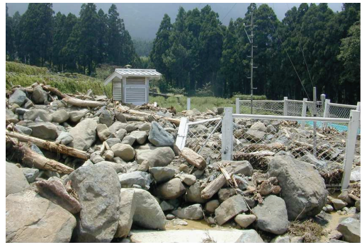
照片 8 2001 年桃芝颱風侵襲期間溪頭氣象站觀測坪遭土石流入侵堆積
