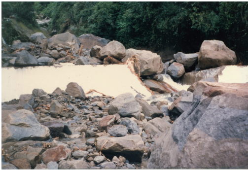
照片 4 1990 年楊希颱風侵襲期間溪頭量水堰遭土石流入侵堆積
