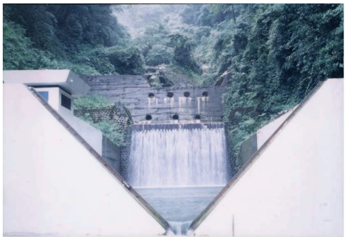
照片 5 1990 年楊希颱風災修後之溪頭量水堰
