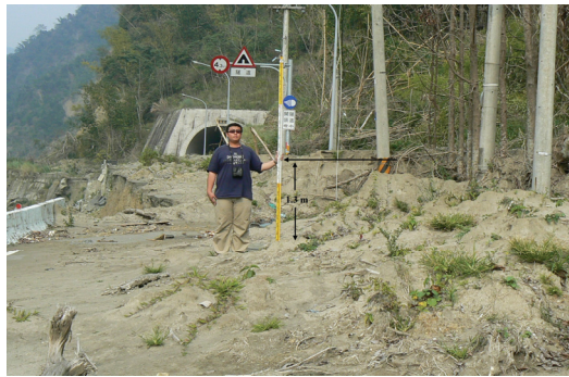
(a)小林隧道前土砂淤積約 1.3m
