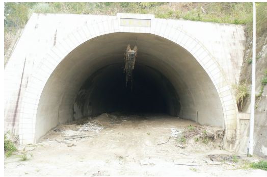
(b)小林隧道上方照明器具卡有洪水後之枯草
