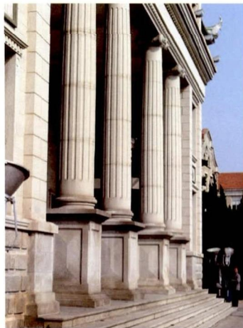
建南楼门面石作立柱
