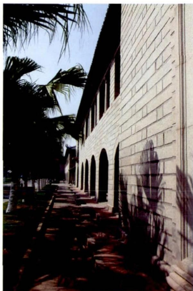
群贤楼群花岗岩清水外墙
