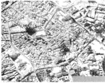
图1 改造中的中山路历史街区
