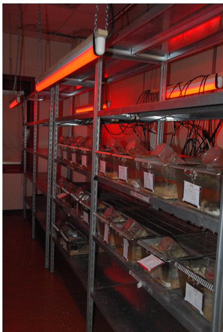
(a) Impianto di illuminazione ausiliario a luce rossa per il campionamento istantaneo ad occhio nudo
