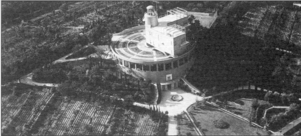
■ 1. veduta aerea di Villa Girasole da sud-est, 1935 ca
