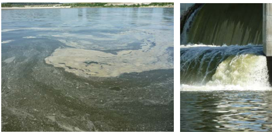
Figura 2.5.23: Risospensione a valle delle paratoie.
