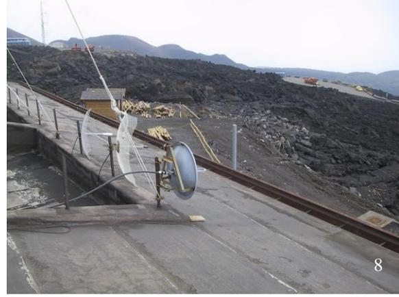
fig. 8 Parabola per trasmissione video dall'Hotel Corsaro al CUAD (Catania).
