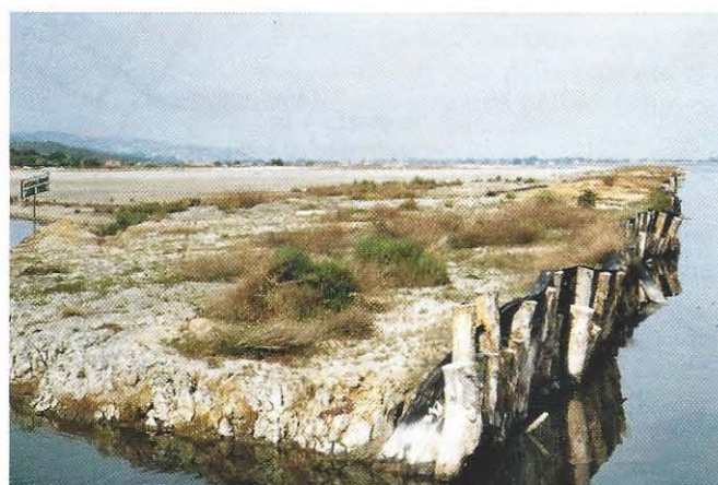
Foto 5 - Ponte Diga: settore orientale prima degli interventi di modellamento morfologico. Ponte Diga: eastern sector before geomorphological modelling.
