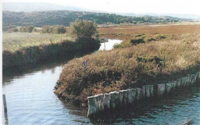
Foto 6 - Ponte Diga: settore orientale dopo gli interventi di modellamento morfologico.
