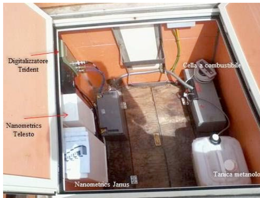
Figura 10. Vano strumentazione EBEL.
