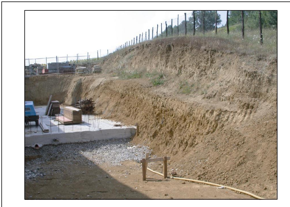
Figura 4.1.6 – Depositi fluvio-lacustri dell’Alta Val Tiberina fortemente limosi con scarsi apporti ciottolosi rinvenuti all’interno dello scavo.
