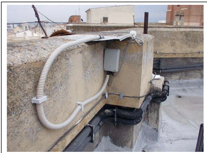
Figura 8. Montaggio della scheda GPS sul terrazzo dell'osservatorio. Il cavo corrugato bianco racchiude l'antenna GPS, posizionata sopra una lastra metallica, che agisce da schermo riflettente e da riparo per la scheda sottostante.
