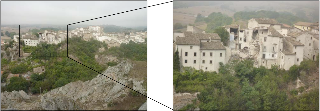
Figura 4. Vista panoramica del centro storico di Castelvechio Subequo con particolare dell'area maggiormente danneggiata dal terremoto de L'Aquila del 6 aprile 2009.
