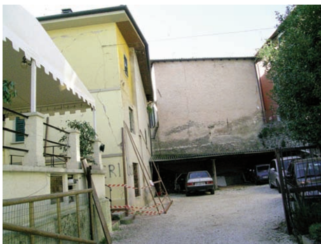
Foto 5-6 Morgnaga e Roè Volciano: lesioni diffuse. Photos 5-6 Morgnaga and Roè Volciano: extensive cracks.
