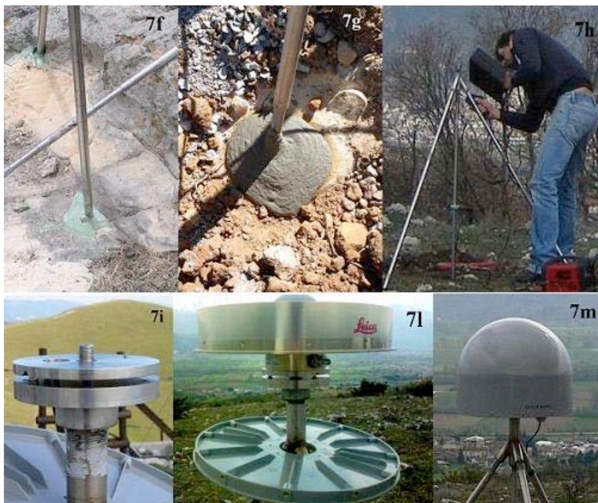
Figura 7 (f, g, h, i, l, m). Fasi di installazione del monumento GPS permanente tipo short-drilled-braced . Per i dettagli si veda il testo.
