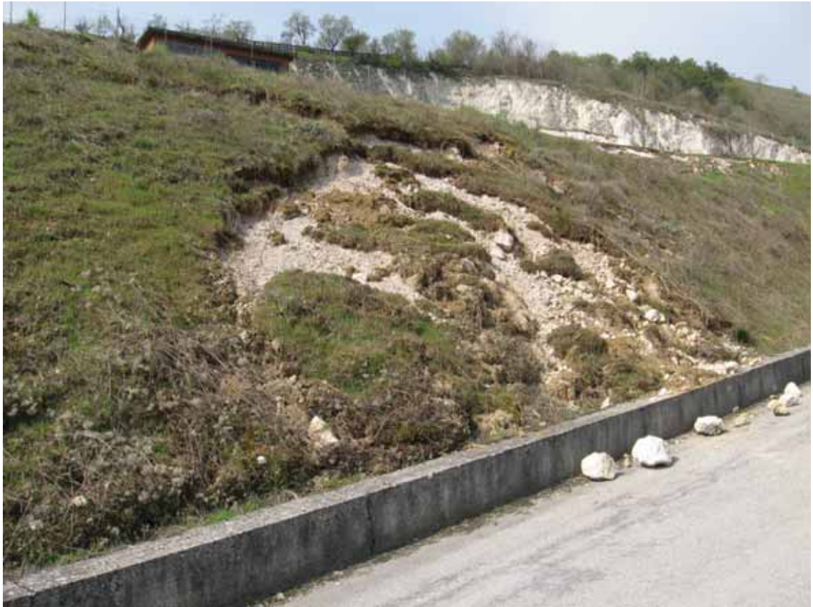
Frana in roccia lungo la strada per Bazzano Rock fall on the road to Bazzano
