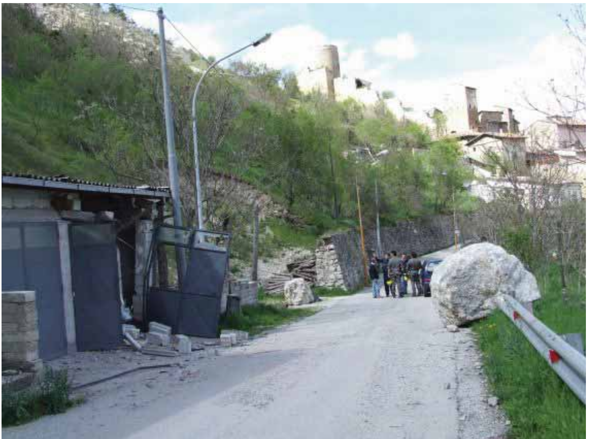
Fossa, blocchi crollati e rotture su asfalto Fossa, mass fall and ruptures on paved road
