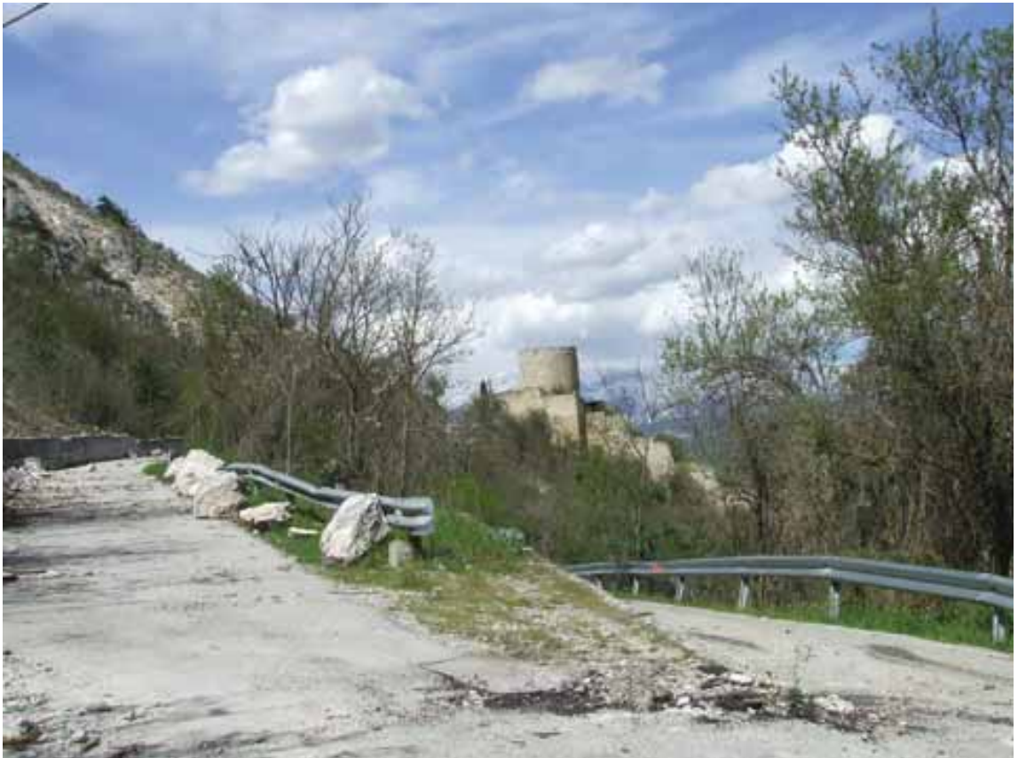
Fossa, blocchi crollati e rotture su asfalto Fossa, mass fall and ruptures on paved road
