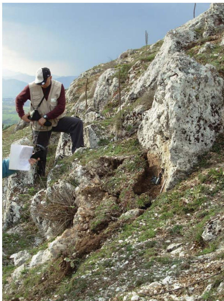
Figura 31 Fessurazioni e scollamento del suolo dal piano di faglia in calcare (WPT SP36, 42.3051/13.4105).
