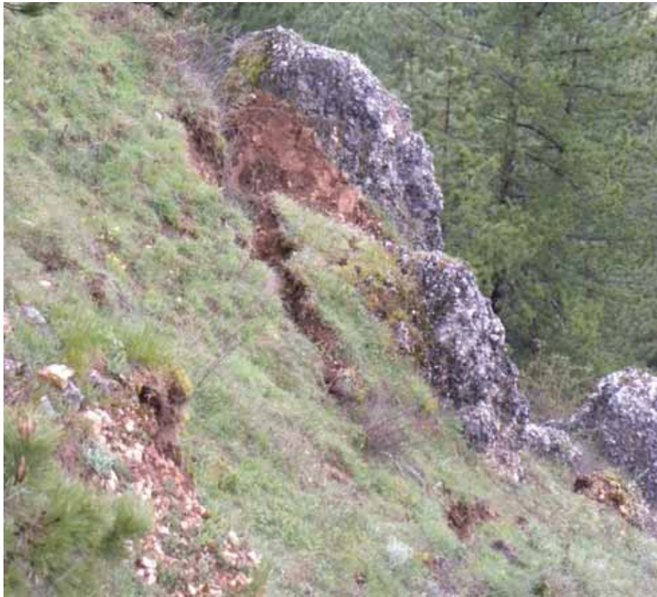
Vallesindola, particolare dell'area in frana Vallesindola, detail of the landslide area
