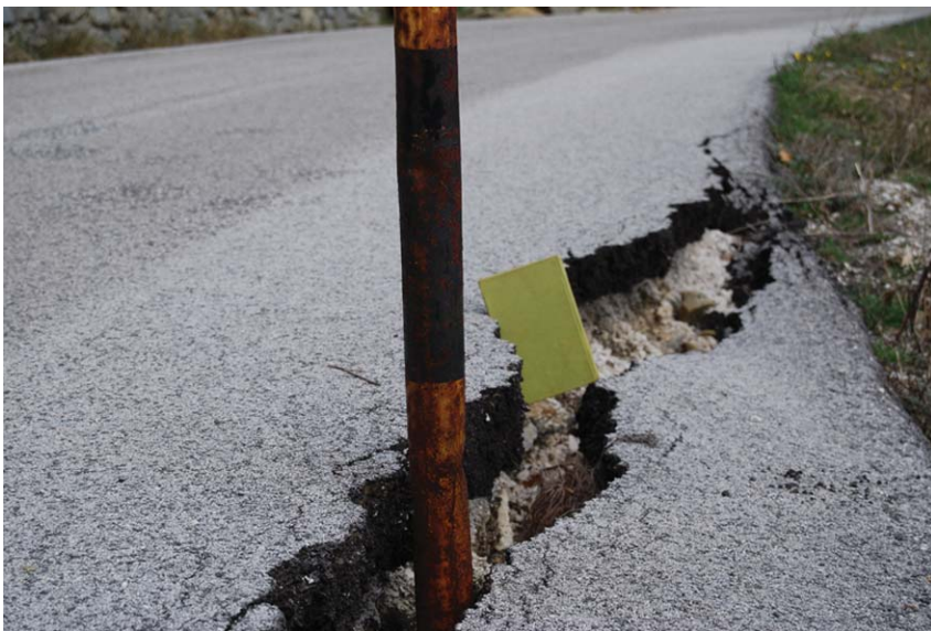
Figure 62 e 63 Frazione di Ortolano: movimenti franosi riattivati. Figures 62 and 63 Landslide reactivation near the hamlet of Ortolano.
