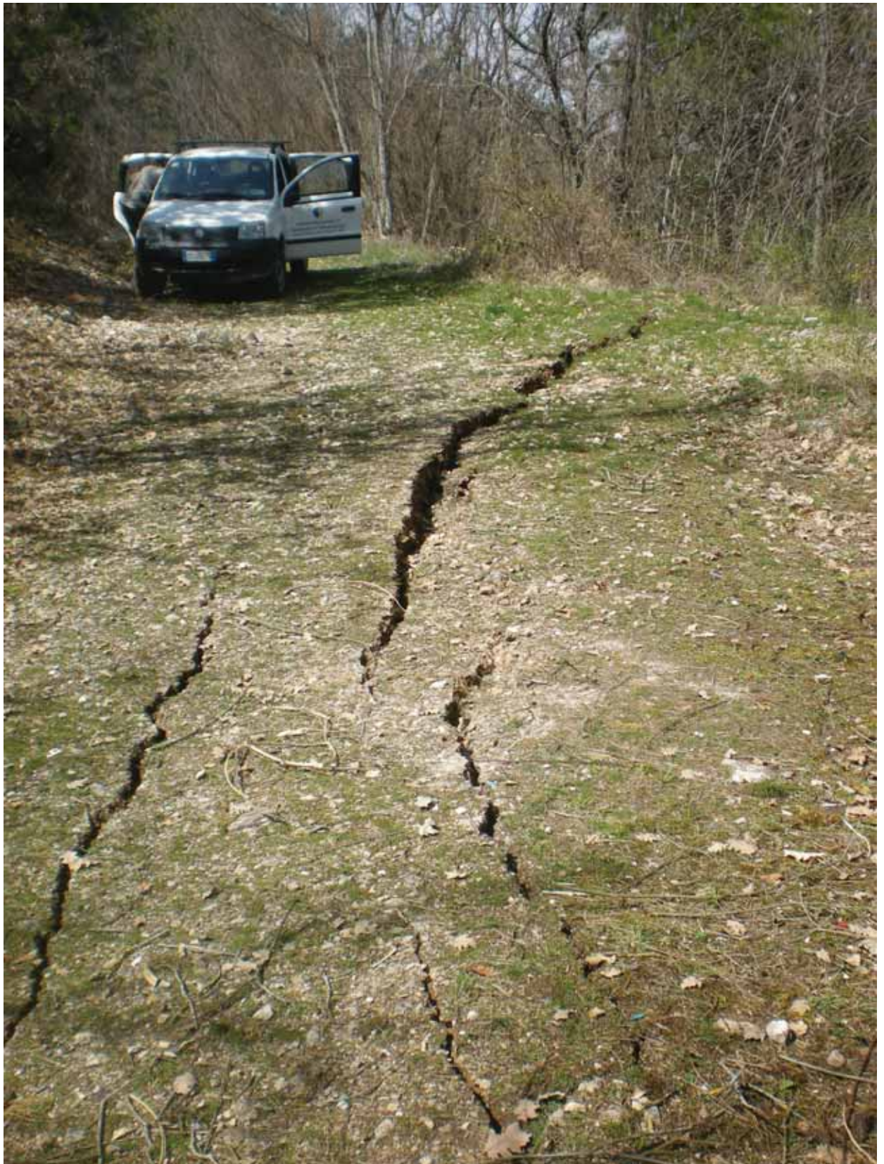
Pianola, fratture beanti nel terreno Pianola, open cracks in the ground
