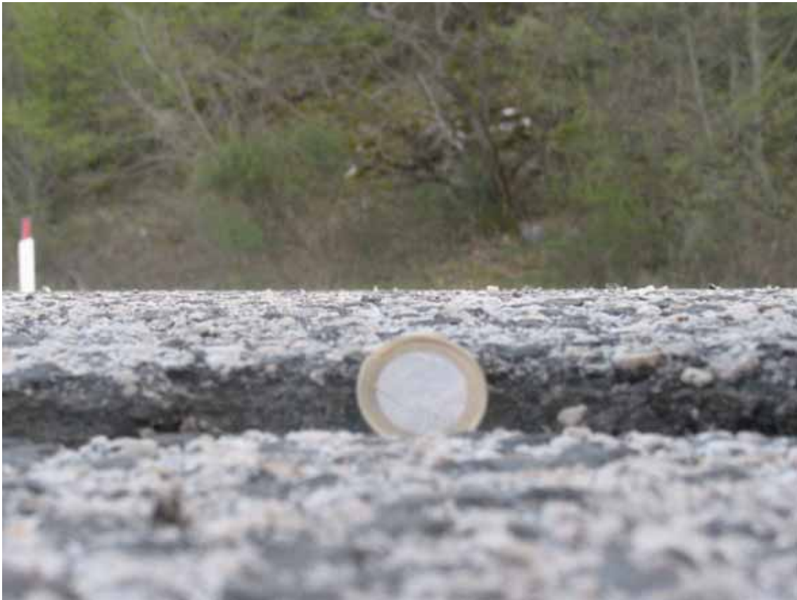
San Panfilo d'Ocre, frattura su asfalto San Panfilo d'Ocre, break on paved road
