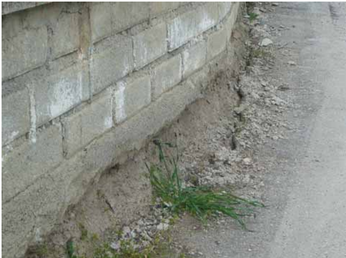
Compressione su asfalto a Tempera Tempera, compression on the pavement
