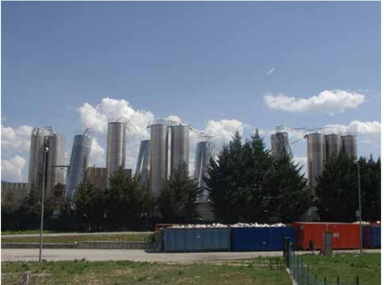
Silos deformati nella zona industriale di Bazzano Deformed silos in the industrial zone of Bazzano
