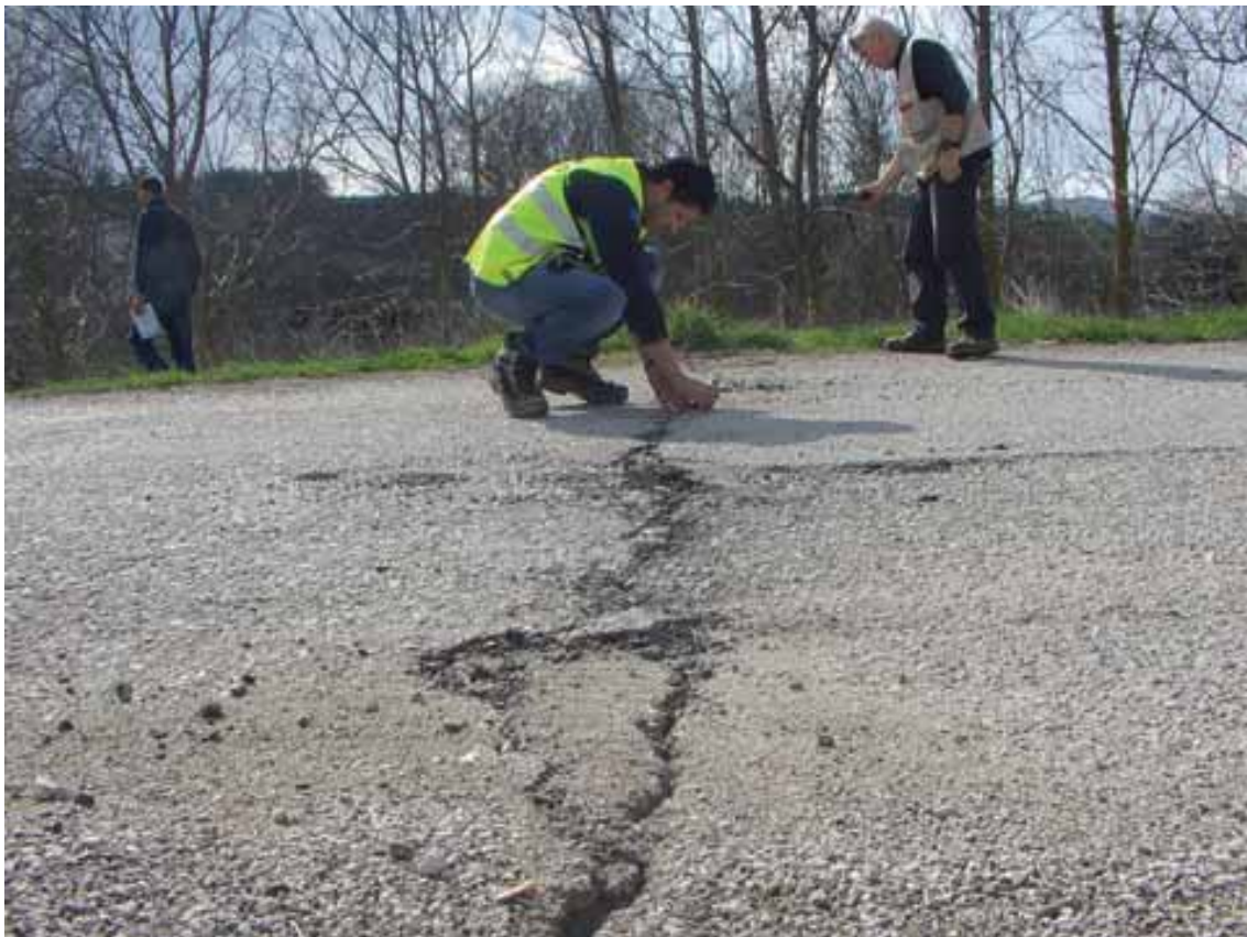
Castelnuovo, frattura su asfalto Castelnuovo, break on paved road
