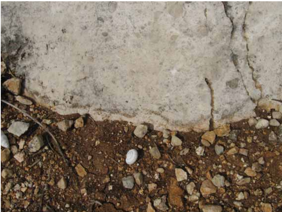
Collebrincioni, scoscendimenti nel deposito di versante Sliding in the slope deposits near Collebrincioni
