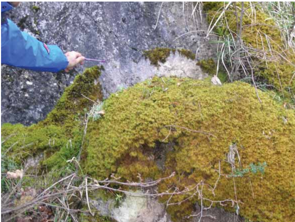
Scivolamento della copertura erbosa su piano di faglia Sliding of the grass cover on the fault plane
