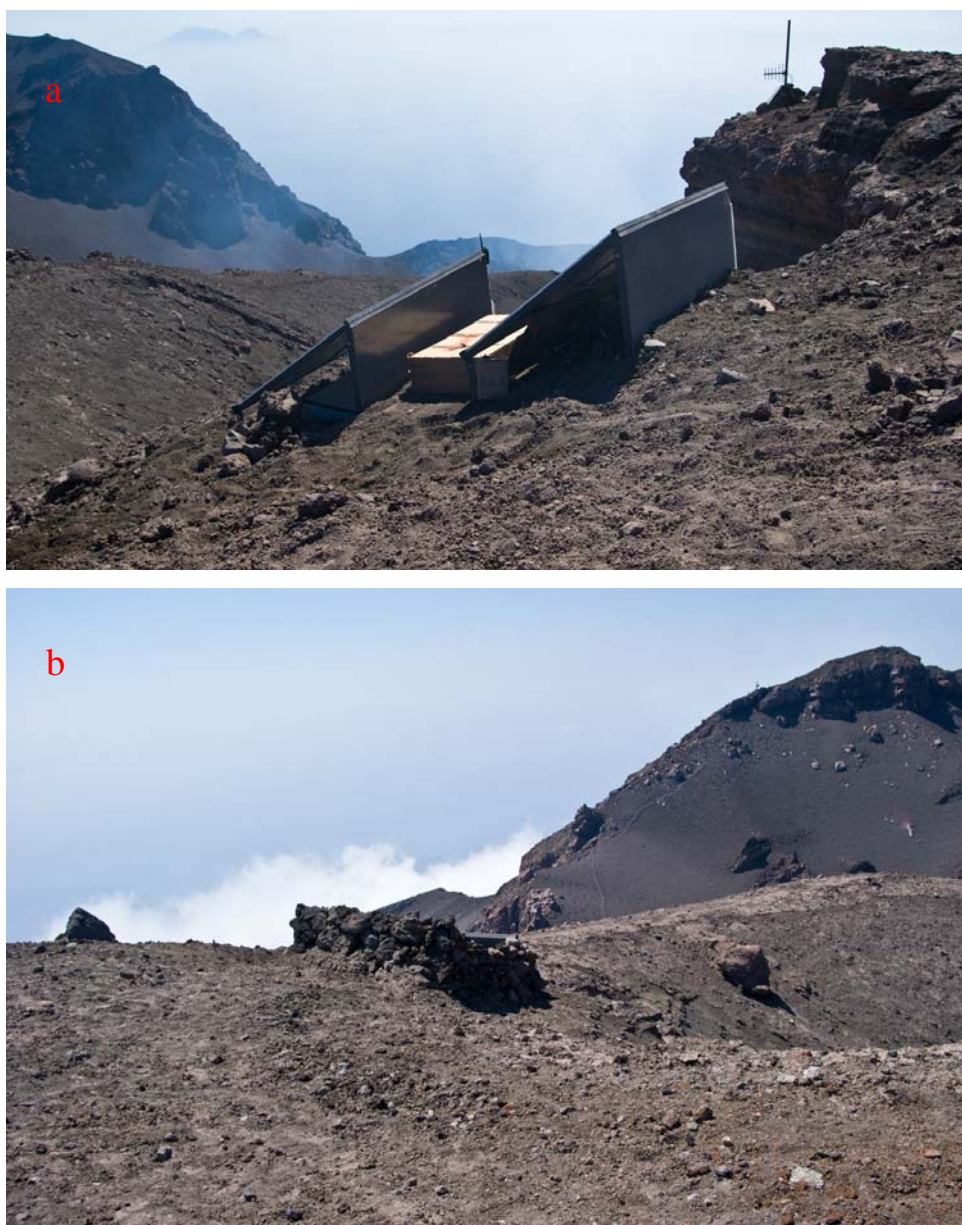
Figura 5- In "a" il sistema di alimentazione. si noti in "b" l'abbattimento dell'impatto ambientale grazie alla realizzazione di un cordone di muro a secco
