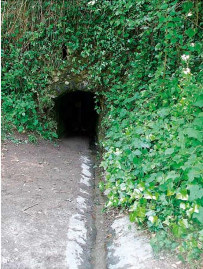
Fig. 8 - Imboccatura della Galleria Olivella 1, con canale di eduazione delle acque in basole di lava giustapposte con sezione a "V".
