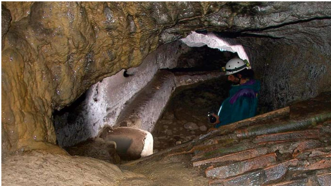
Fig. 14 - Opera di convogliamento delle acque di stillicidio della Galleria Olivella 2, realizzata con gruppo di tegole rovesce in cotto e canale di adduzione sulla parete sinistra. Notare in fondo la vaschetta concrezionata da dove le acque traboccano nella vasca principale.
