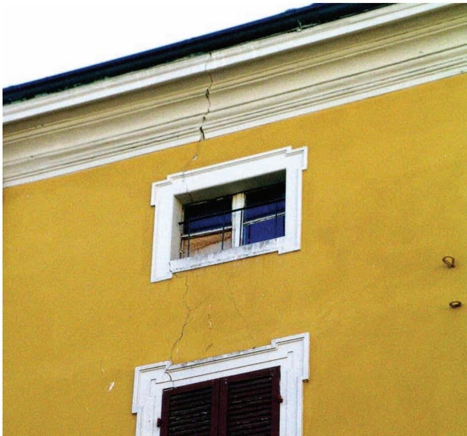
**Foto 17** Langhirano: esempio di lesione passante in edificio in muratura.
