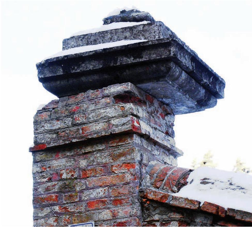
**Foto 12** San Vitale di Baganza (Sala B.): slittamento e parziale rotazione del capitello di una colonna in un muro di recinzione.
