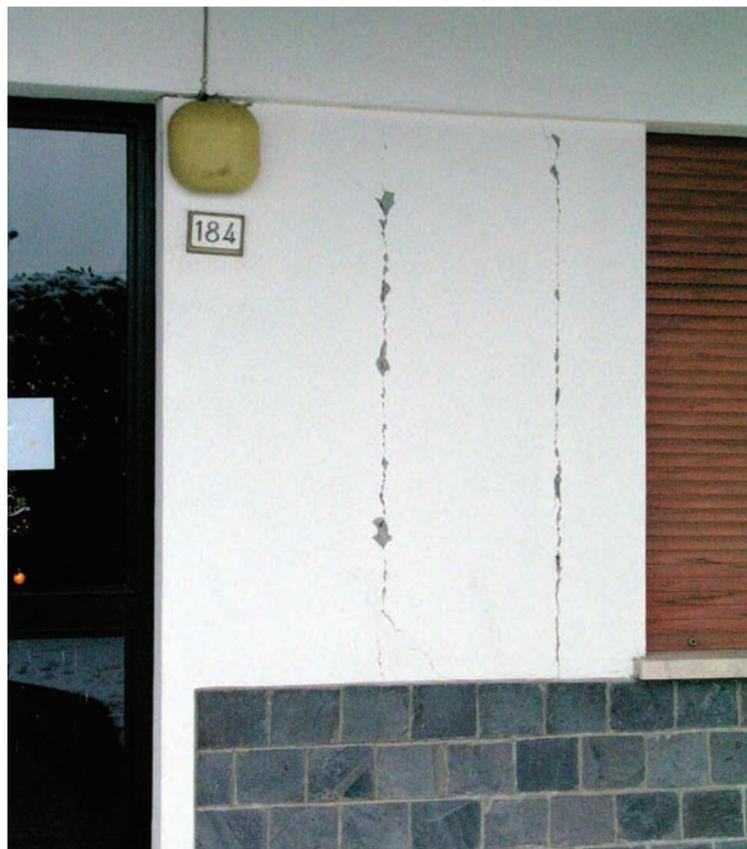
**Foto 4** Poggio S. Ilario (Felino): lesioni fra pilastro e tamponatura in un edificio in c.a..
