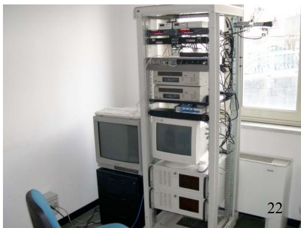
Figura 22. Il rack installato nella sede I.N.G.V. di Niclosi contenente la stazione video ricevente, i sistemi per l'inserimento della data e dell'orario, i sistemi di acquisizione, di digitalizzazione, di archiviazione, di visualizzazione e di trasferimento dati in tempo reale alla sede di Catania.
