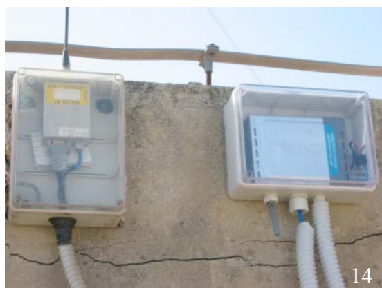
Figura 14. Il radiomodem ed il trasmettitore wi-fi posizionati sul tetto della scuola media, utilizzati per il controllo della telecamera Canon e per il controllo ed il trasferimento dei dati radiometrici dalla telecamera Flir A 40 M..
