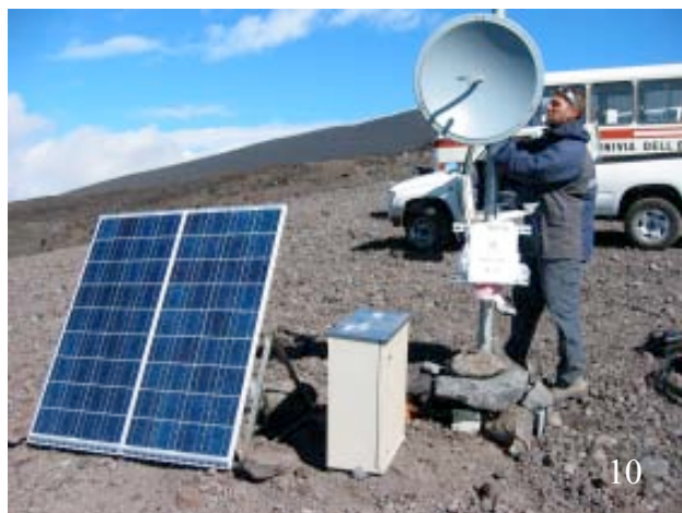
Figura 10. Test di trasmissione video a 10 Ghz effettuato dall'Etna, in prossimità della stazione di arrivo della Funivia a quota 2550 m s.l.m., verso Catania (25 Km).
