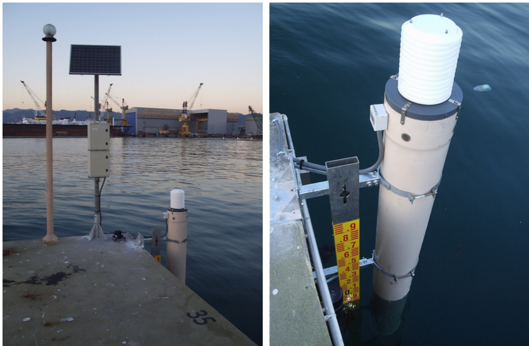
Figura 2. La stazione mareografica standard (APAT) installata sul molo esterno di porto Lotti all'interno del porto della Spezia con, in dettaglio, l'idrometro ad ultrasuoni.
