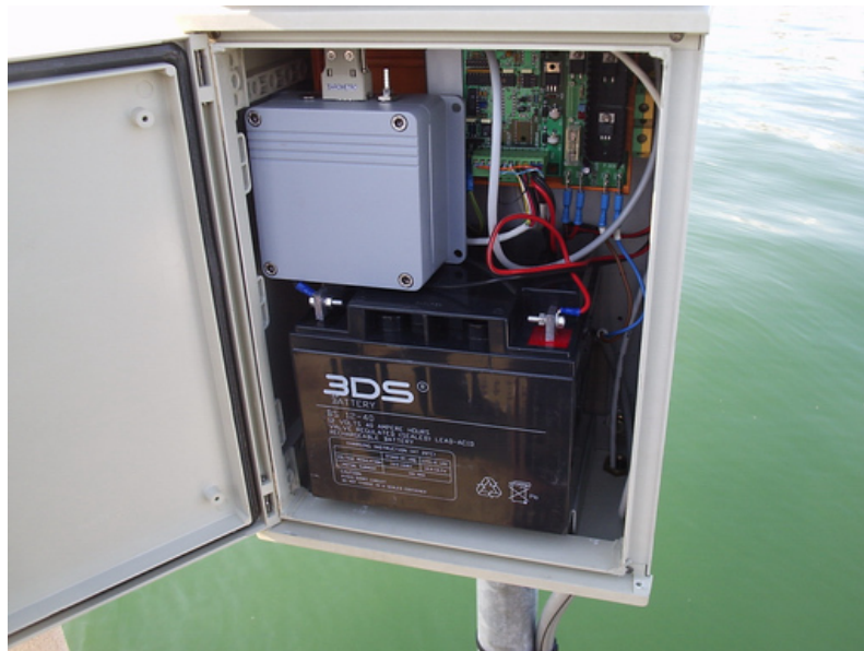
Figura 3. Il barometro sistemato all'interno del vano batteria della stazione mareografica standard.
