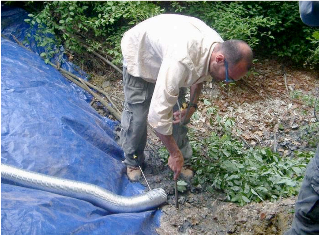
Foto 7. Messa in posto del telone impermeabile del SAP e fissaggio del bordo al perimetro della polla di Colle Monticchio con uso di picchetti metallici. (foto: S. Mecozzi)
