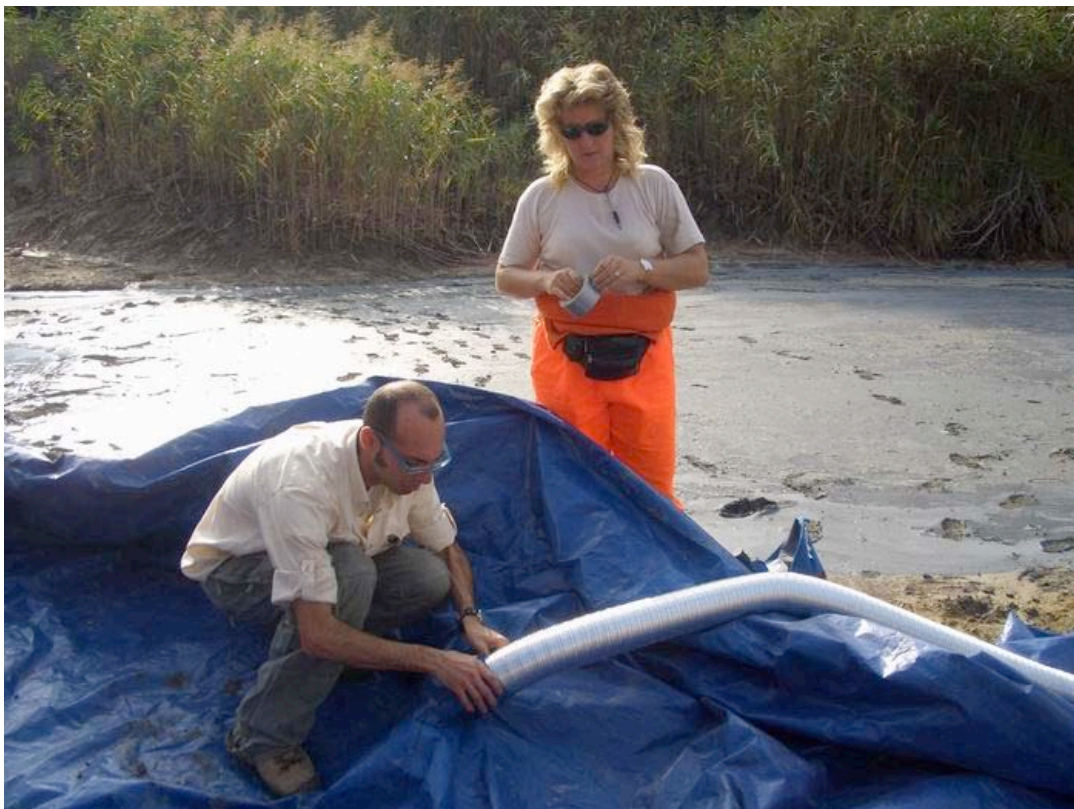
Foto 11. Montaggio del SAP nelle vicinanze dei siti EG1 ed EG2 di Palidoro. Particolare della verifica di tenuta delle giunture dei tubi corrugati a cui verrà apposta la sonda “a filo caldo”. (Foto: S. Mecozzi)
