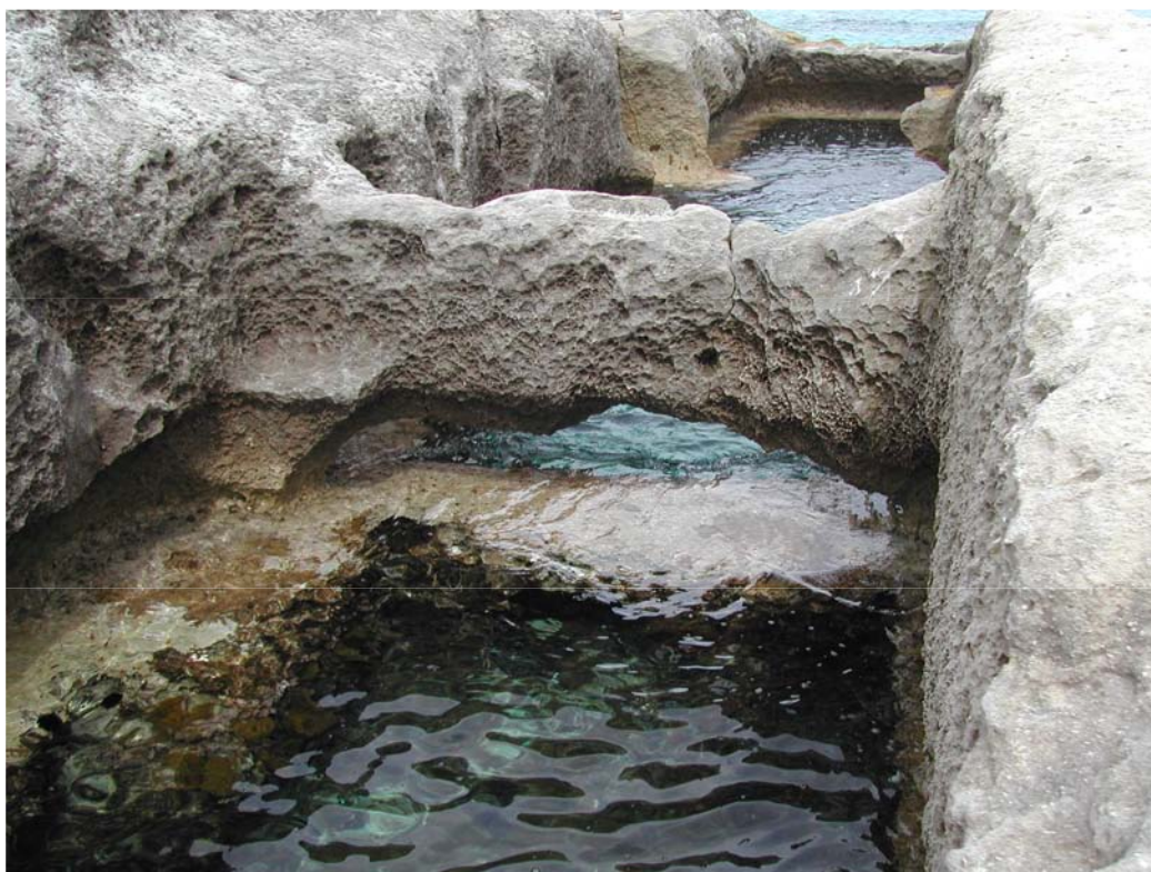
Fig. 8 - Particolare dei setti divisorii erosi dall'azione meccanica del mare, al di sotto dei quali corrono i canali di comunicazione tra le vasche.
