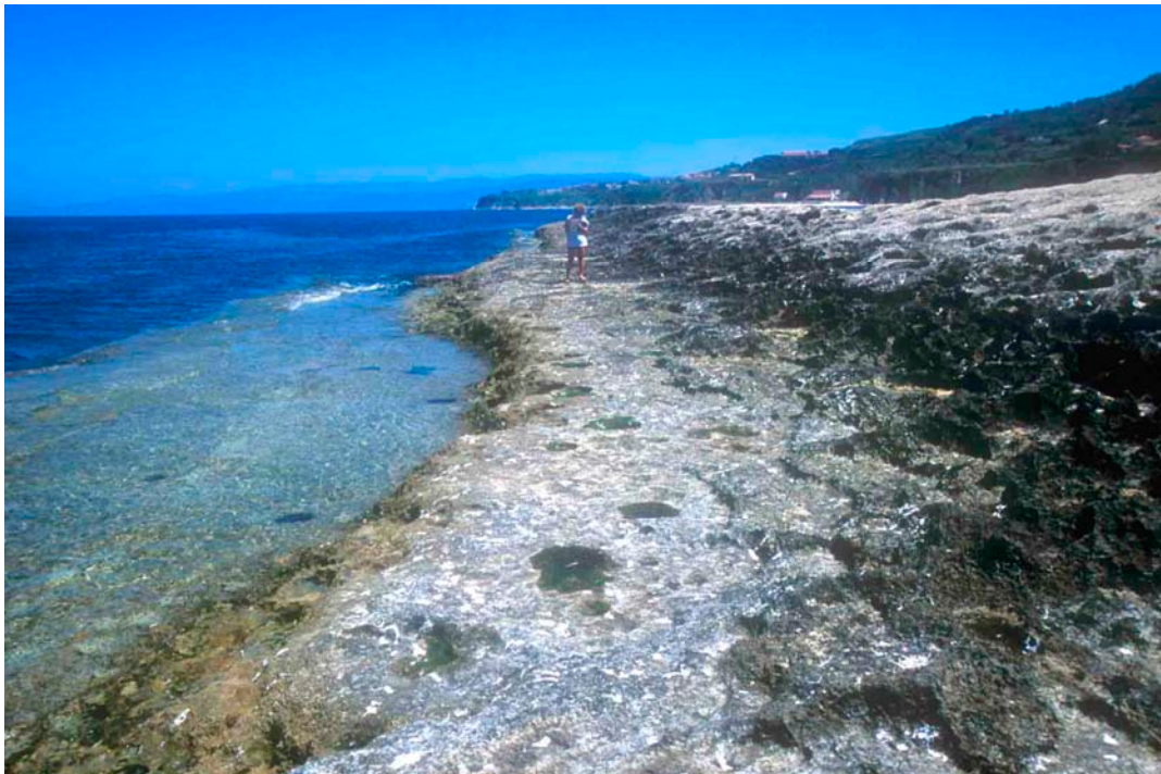
Fig. 11 - Piattaforma di abrasione con colonie di Dendropoma . Su questa sono presenti numerosi fori realizzati per inserire i pali in legno per le casseforme, un frammento dei quali ha permesso di datare l'impianto a 1806 \pm 60 anni fa.
