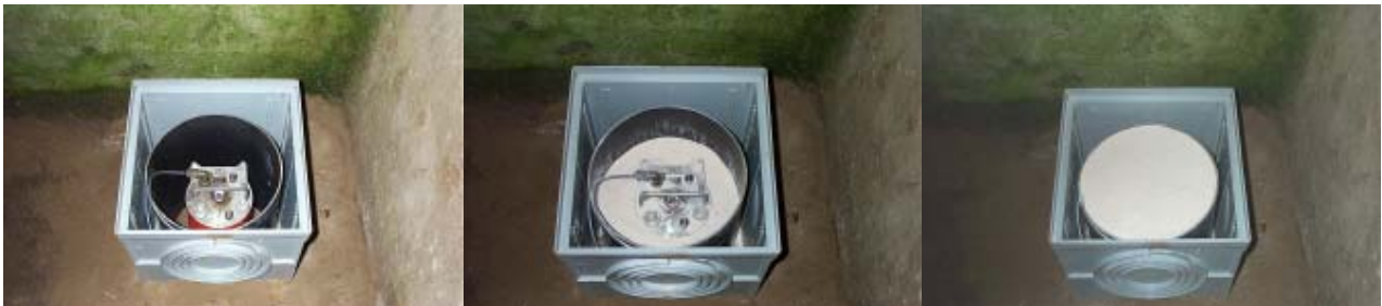
Figura 4 – Installazione del sismometro Geotech S13 alla stazione di Baia (BAC)
