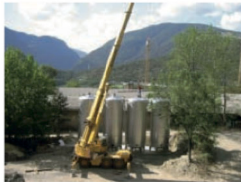
Bild 6: Die Behälter für die Kaskadenfermentation werden aufgebaut
