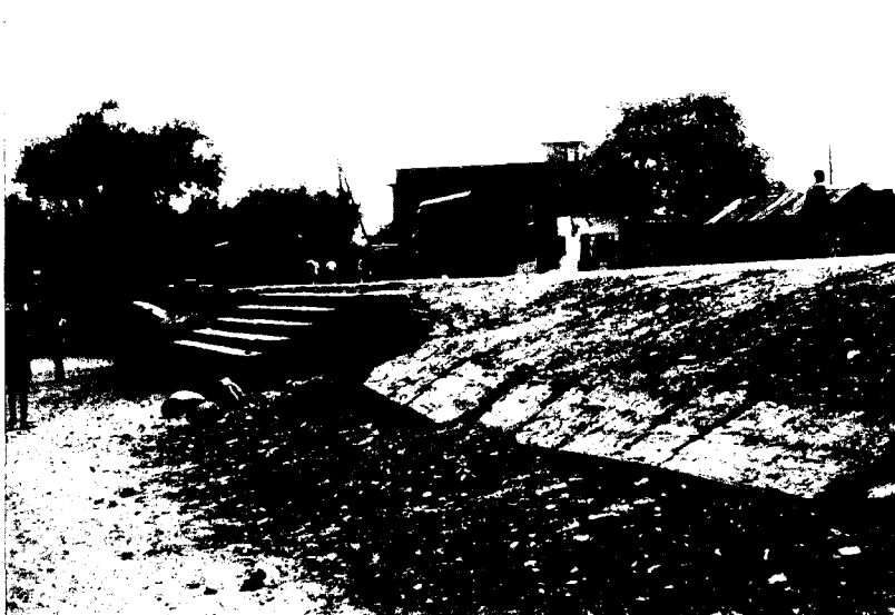
Pas d'entretien, un trafic important, la chaussée de l'avenue principale s'effondre
