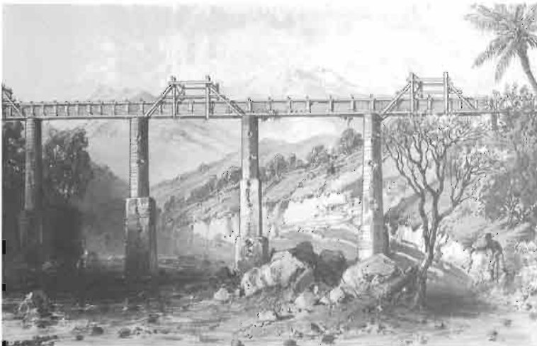
Aqueduc Chabrier dans la ravine du Gol à Saint-Louis destinée à alimenter la sucrerie du Gol (lithographie d'Hastrel, 1836)
