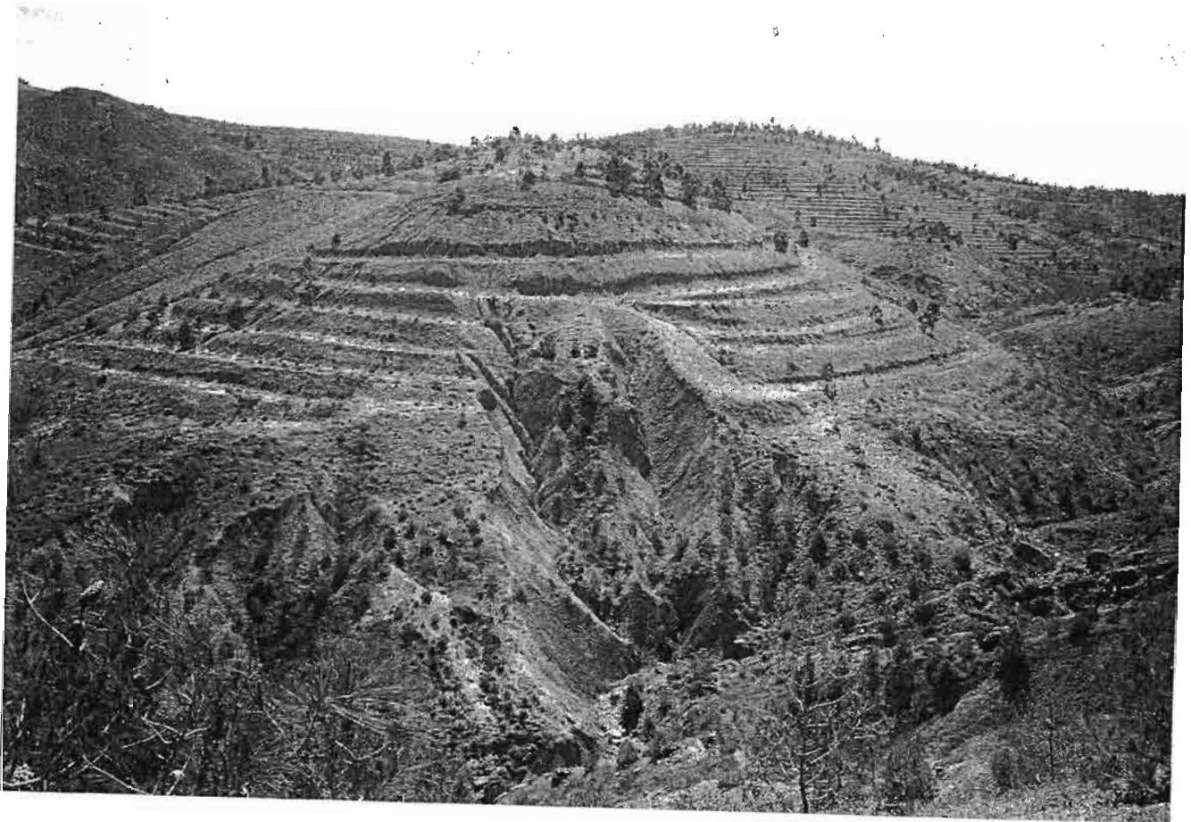
Fig 4. Aménagement en banquettes forestières plantées en Pin d'Alep depuis 17 ans dans la région de Mascara (Algérie). Echec de la plantation en zone surpâturée et de l'aménagement car le ruissellement continue de raviner.
