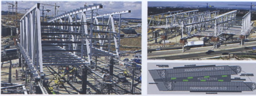
Рис. 6. Гараж-мост Neue Messe, конструктивное решение. Штутгарт, ФРГ
