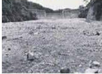
災害後(12万m 3 の土石流を貯留) ちよりゅう
