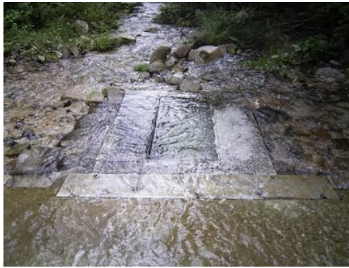
写真1. 2 ピット流砂計測装置状況(西滝ヶ谷)
