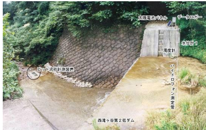
写真1.1 観測機器の全体配置状況(西滝ヶ谷)
