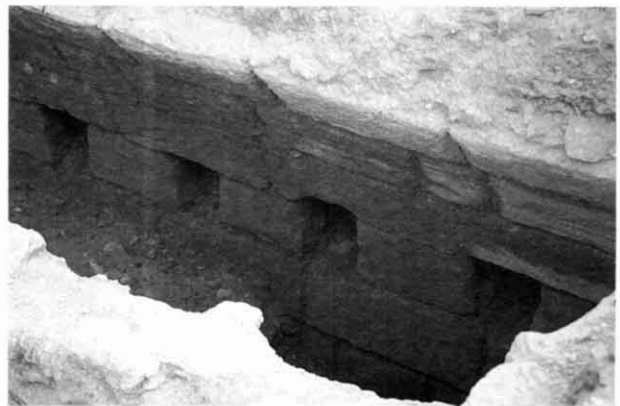
Làmina 5. Detall de l'interior de l'estructura d'emmagatzemat a l'interior de la torre A.
