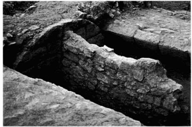
Làmina 4. Estructura d'emmagatzemat a l'interior de la torre A.
