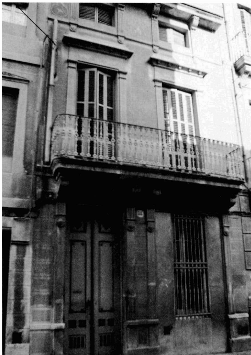
Era freqüent l'acondicionament de refugis als soterranis de les cases. Carrer Doctor Santponç, 35.
