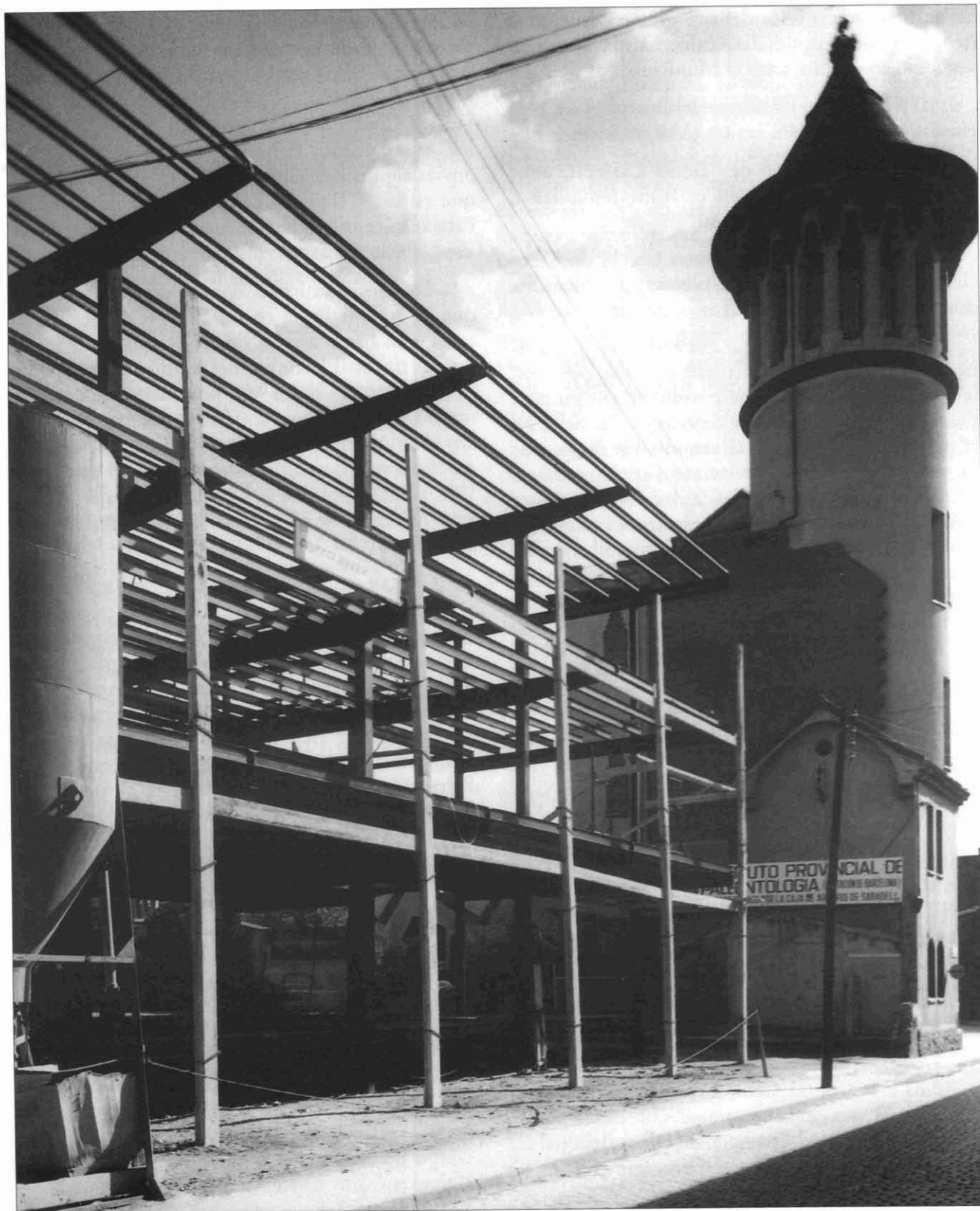
FOTOGRAFIA 4. L'Institut de Paleontologia en construcció, el 1968.
