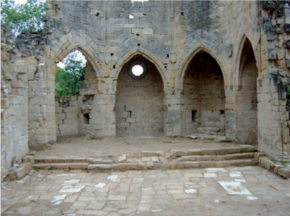
Figura 3. Detall de l'interior de l'església després de la intervenció del 2008.
