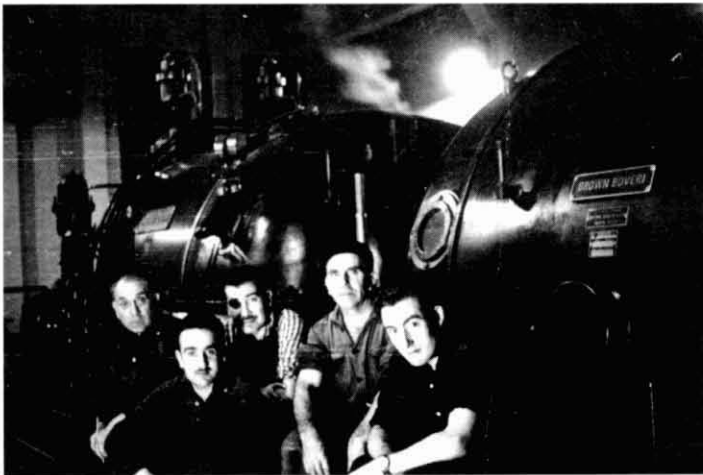
Un grup de treballadors s'encarregava del manteniment de la turbina de vapor, una Brown Boveri, que generava una potència de 14.000 kw/hora. ARXIU LUIGI
