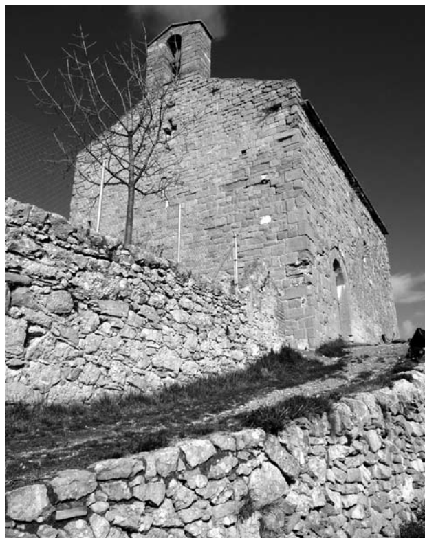
Vista des de ponent de l'església; en primer terme, el mur de contenció de la rampa que facilita l'accés a l'interior del temple, i, en segon terme, la paret del cementiri.
