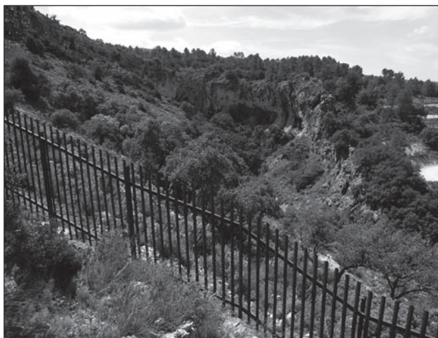
Vallado perimetral instalado en 2009.
