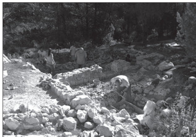
Treballs de consolidació dels murs del sector 11 Fb del Puig d'Alcoi.
