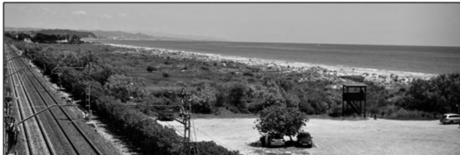
Perspectiva de part de Salats i Muntanyans des de dalt del pont de la via.
