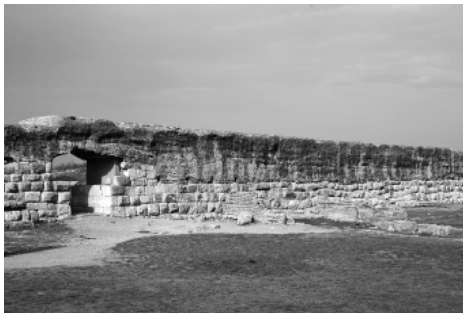
Muralla sud de la ciutat romana, construïda amb sòcol de pedra i un cos superior de formigó.
