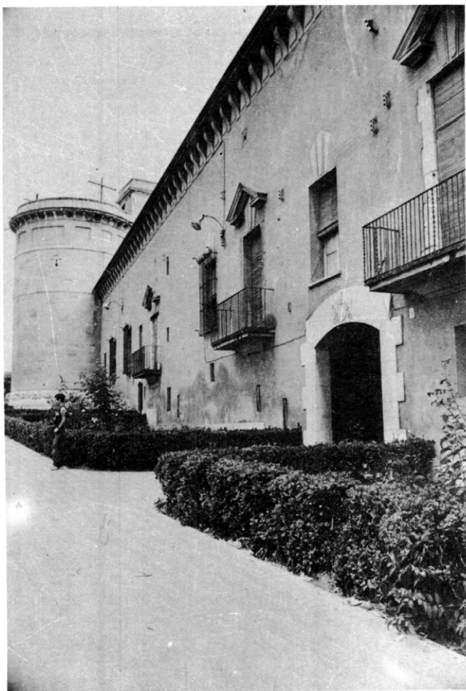
Vista general de la façana
