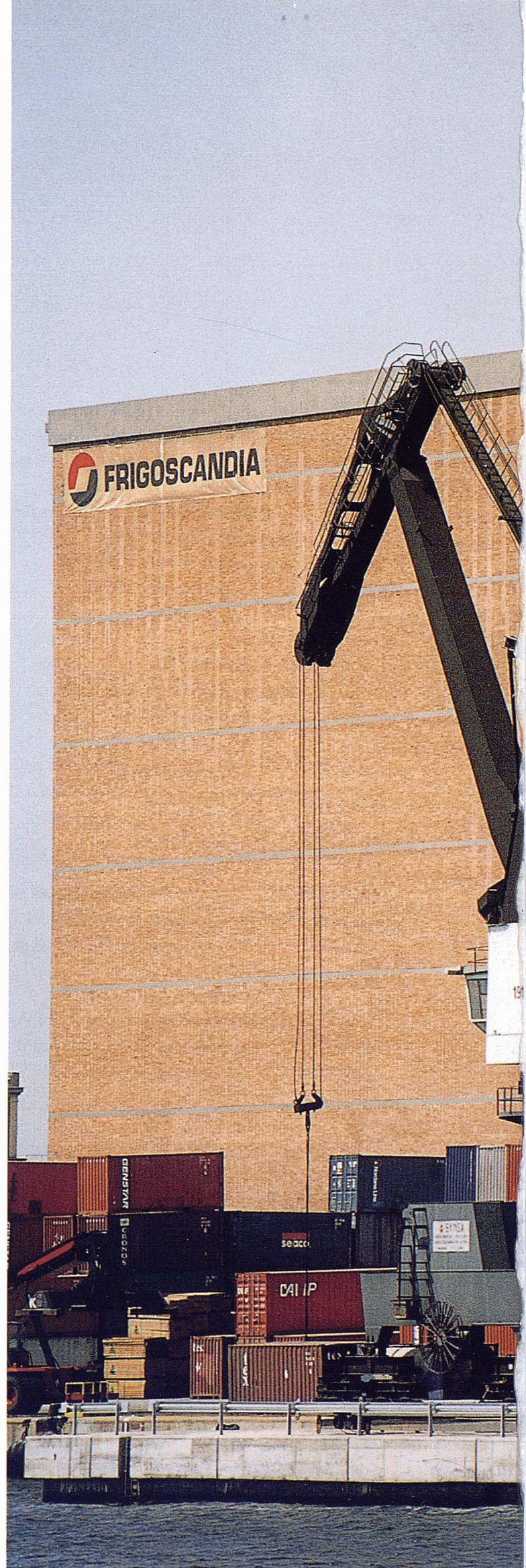
Grúa pòrtic. Port de Barcelona. R. Moreno
