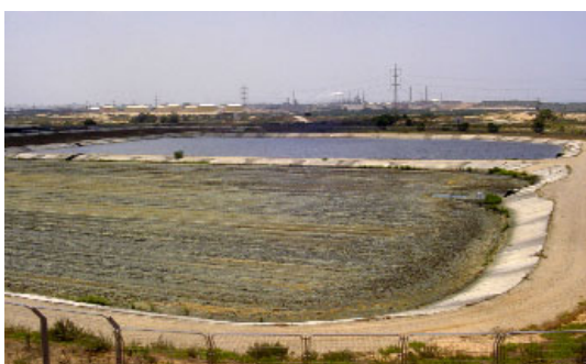
Fig. 5: Balsas de recarga artificial de acuíferos. Al fondo se observa una balsa llena (en proceso de recarga). Al frente una balsa en la que se acaba de realizar un tratamiento para eliminar la colmatación de la misma (mediante arado de la superficie).
