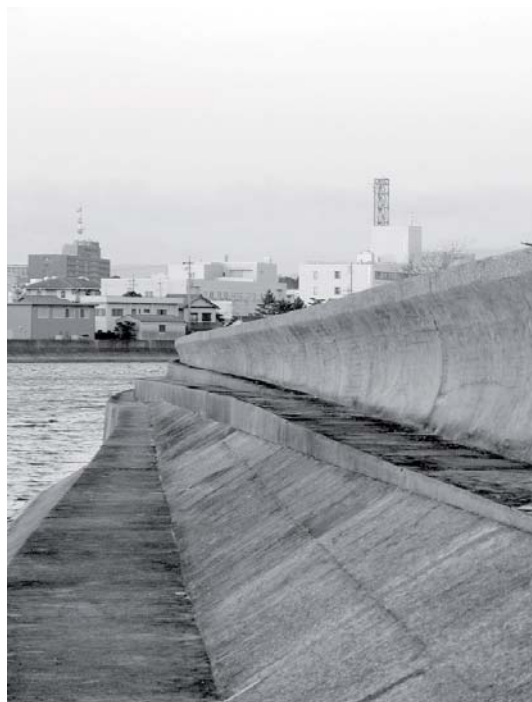
Fig. 5. Tipo de rompeola diseñado en Tsu-Shi (Japón) como defensa contra tsunamis. Fuente: www.flickr.com/photos/rka/3229041/ .
