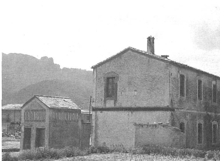
A Sant Esteve, el Puigsacalm, encara guarda l'edifici tancat i emparedat.
