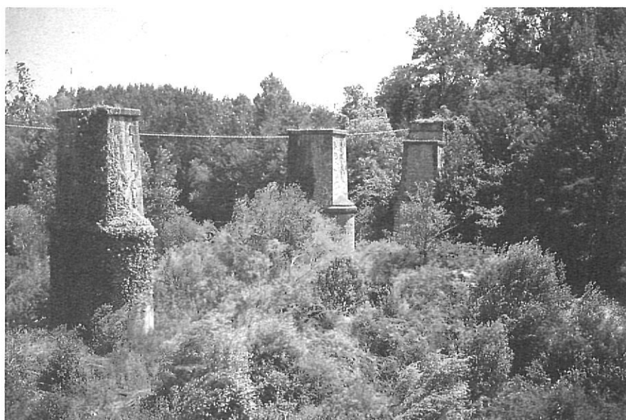
Del pont del Pasteral, el més important de la línia, avui tan sols en queden els estreps que donen una imatge de perfecta desolació.
