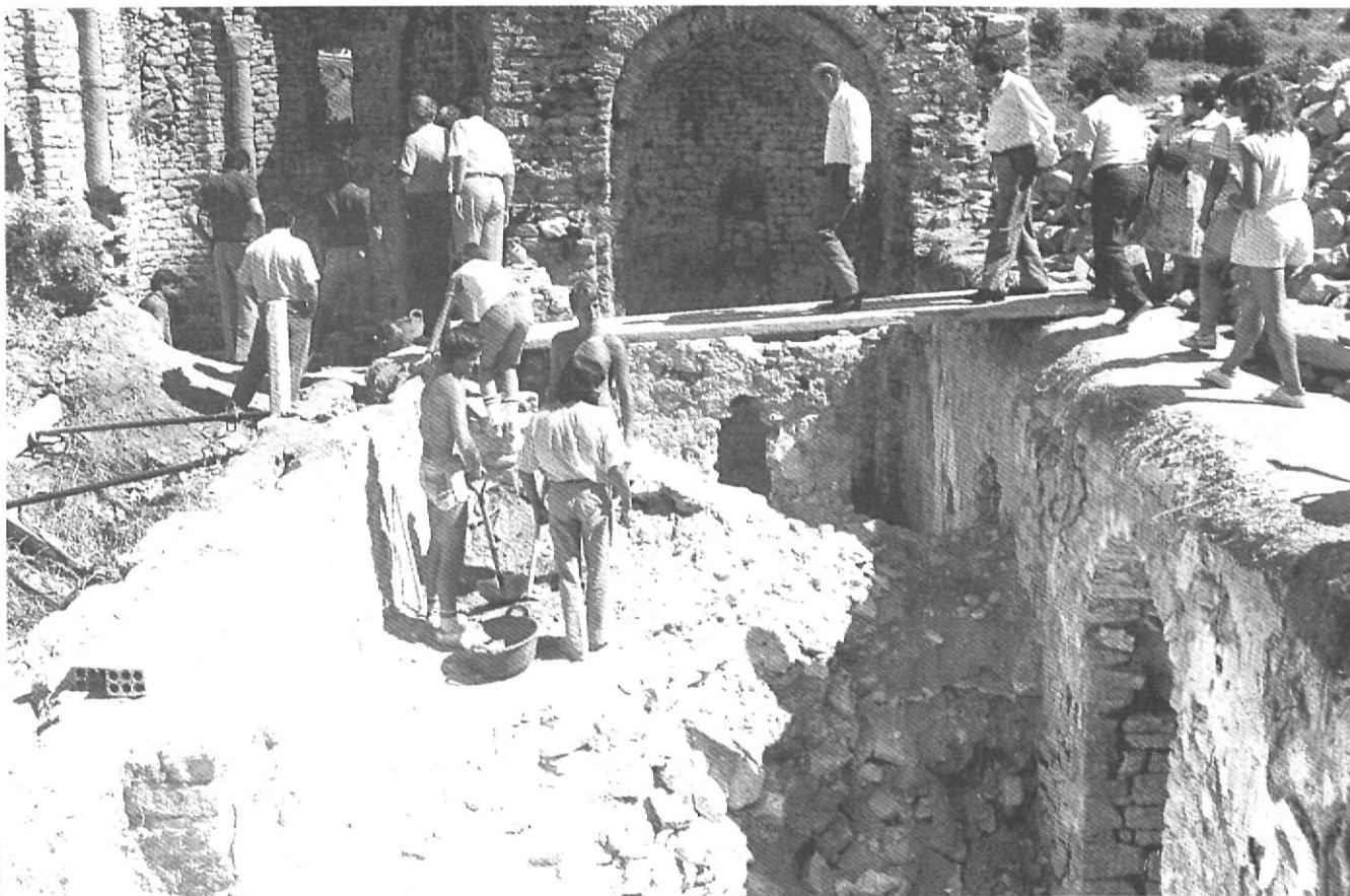
Els treballs d'excavació de 1985.
