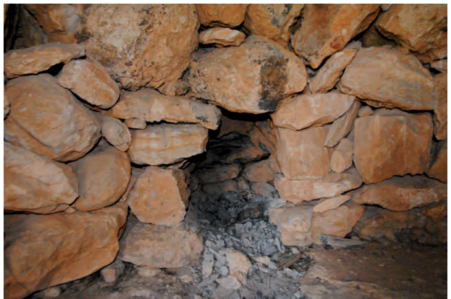
■ Els armaris oberts arran de terra reben a la zona de Mont-roig del Camp el nom de «cocons». Feien la funció d'armaris frescals, ja que mantenien frescos l'aigua, el vi i alguns queviures. A la imatge, el cocó de la barraca del Miquel Terna, reutilitzat com a foc a terra.
