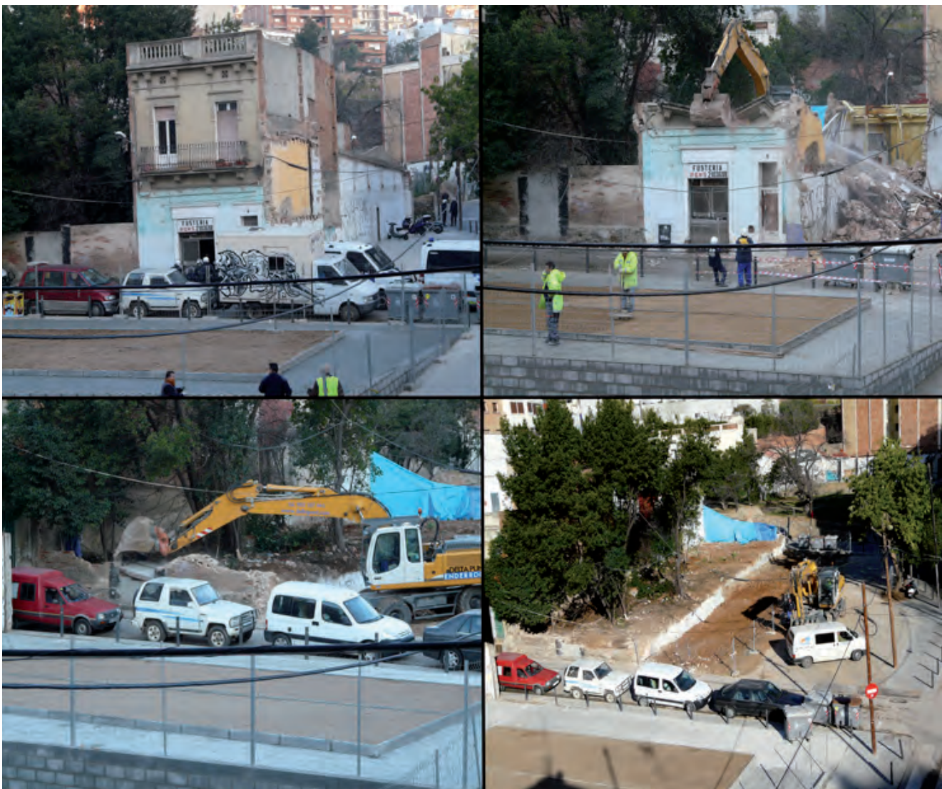
■ Desallotjament, enderrocament, condicionament i solarització de l'espai on sorgeix l'Hort de Vallcarca (2010). JORDI MORENO
