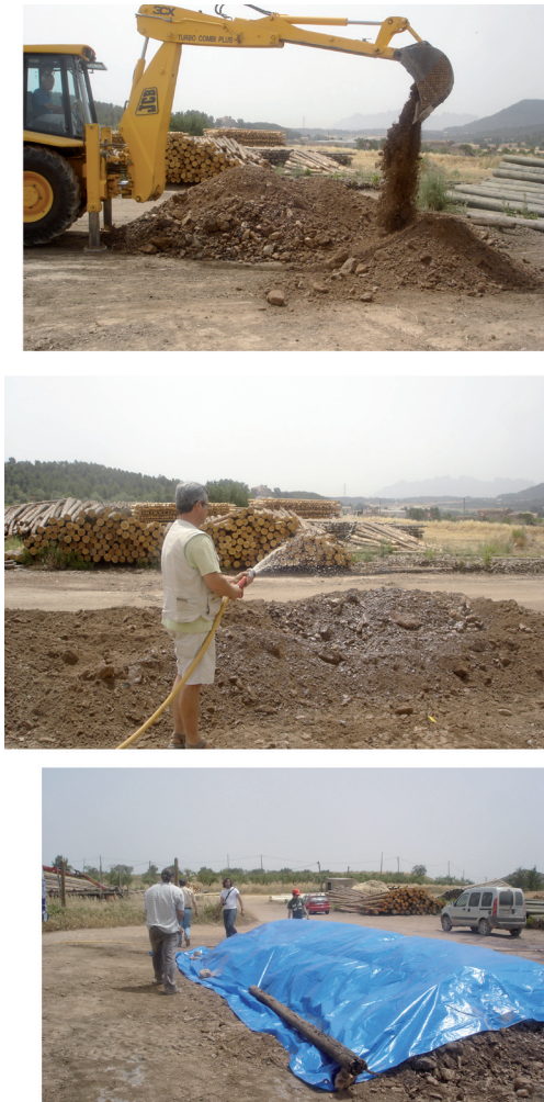
FIGURA 4. Construcció i manteniment de la biopila dinàmica.
