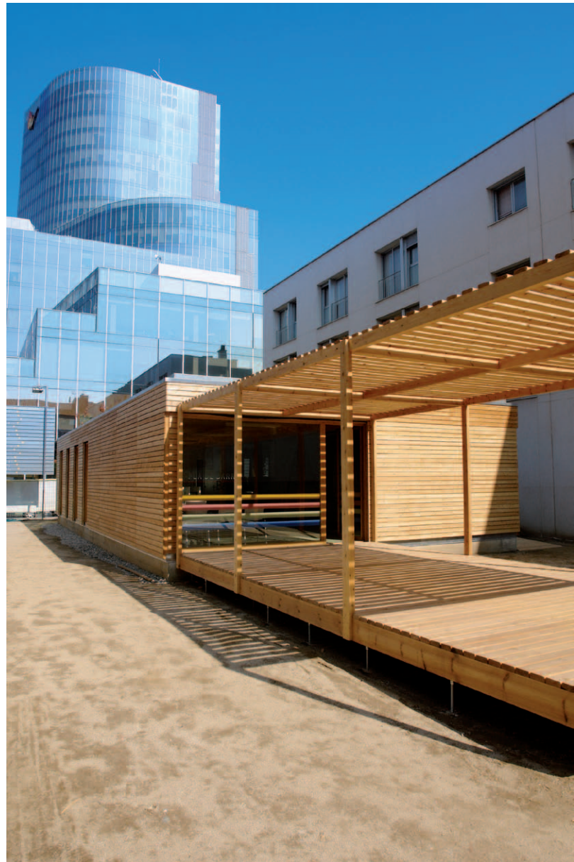
▲ Taller Barceloneta ◀ Montaje de estructura con paneles estructurales de madera contralaminada
